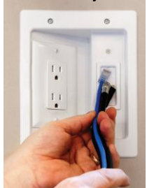
Running A/V Cables Ejecutan A / V Cables
