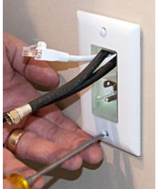
Installing Power Inlet Instalación de Power Inlet
