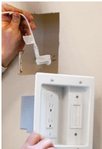
Running Power Cable Cable de alimentación
